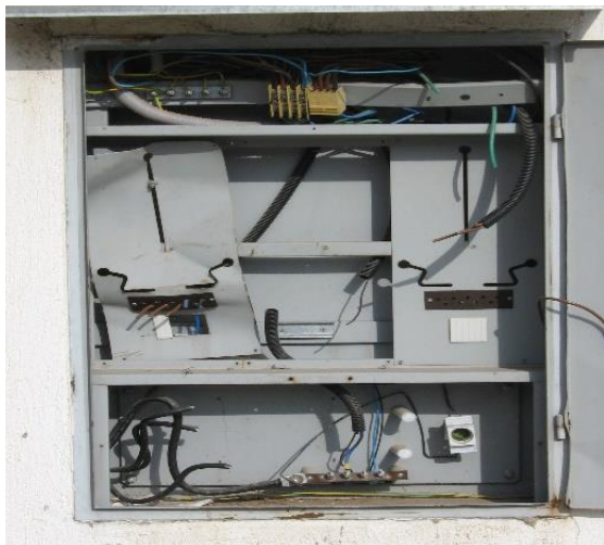
Slika 2. Jedan od mnogobrojnih uništenih/opljačanih razvodnih ormarića za struju
